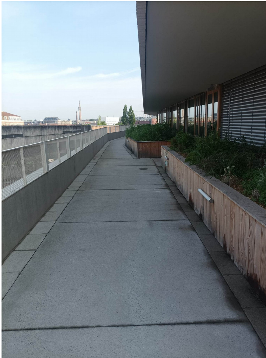
Fig. 13 : Photo du balcon situé au deuxième étage.
